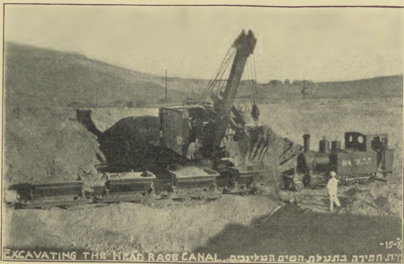
Ruthenberg-művek. Az új Jordán-csatorna építése
