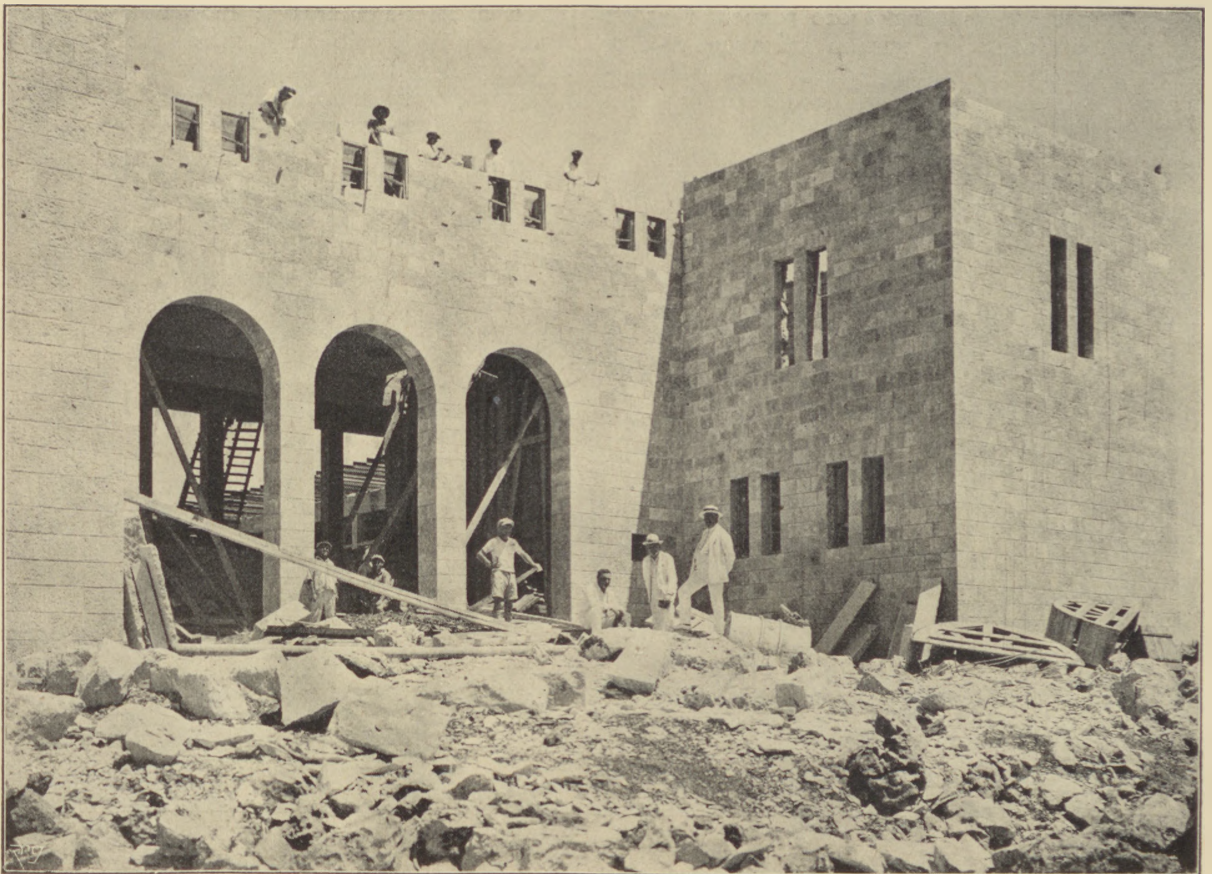
A jeruzsálemi héber tanítóképző építés közben.
