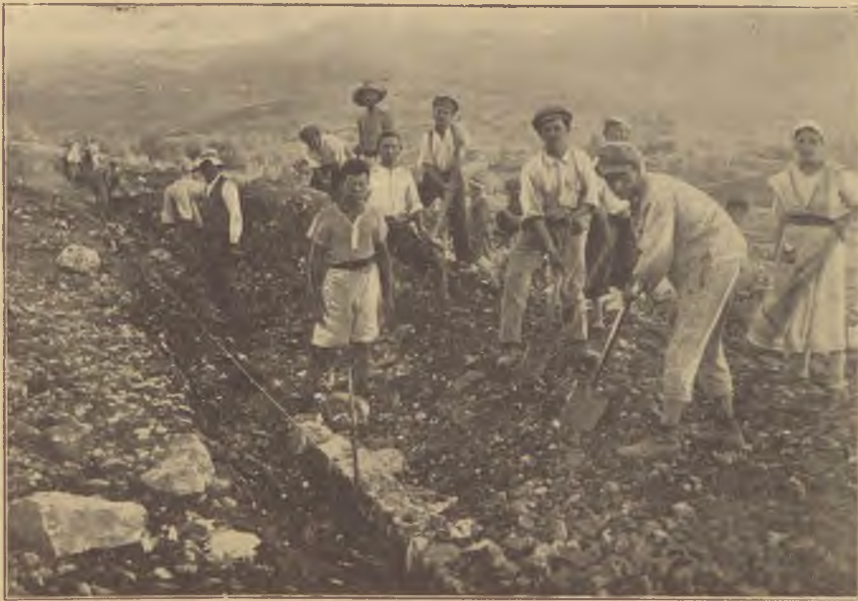
Utépítés egy új kolónia mellett Wegebau bei einer neuen Ansiedlung Construction de chemins près d'une nouvelle colonie
