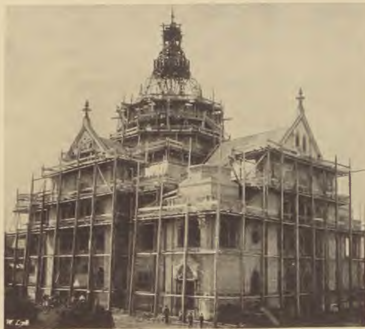
La nouvelle synagogue de Szeged en construction.
