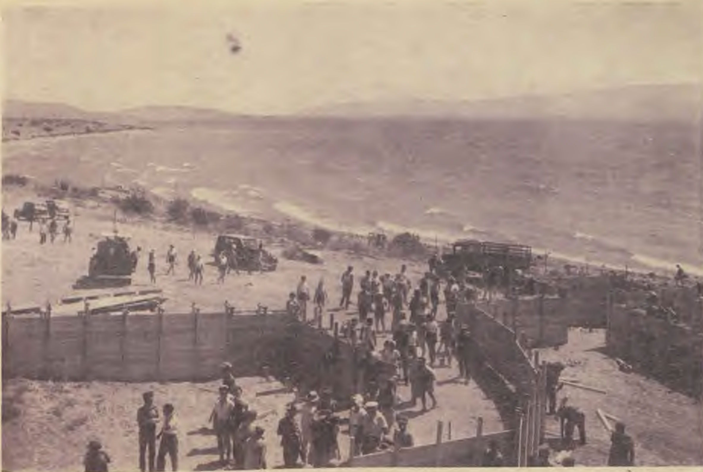
Batelem. A telep bejárata a Kineret felől
