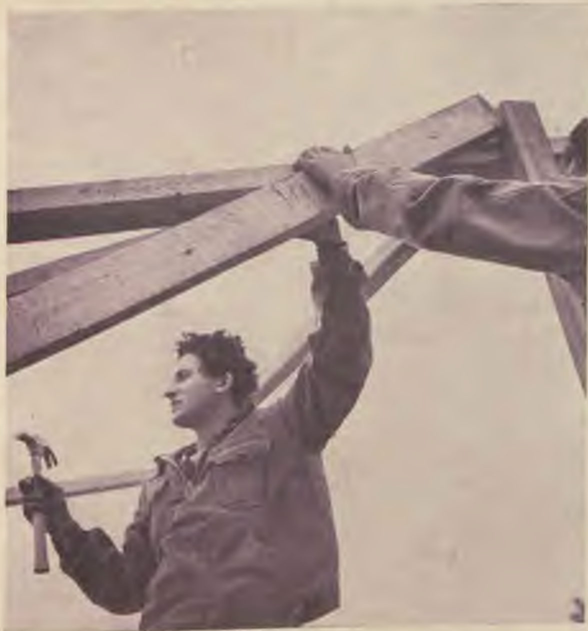
Chanita. Az őrtorony építése
