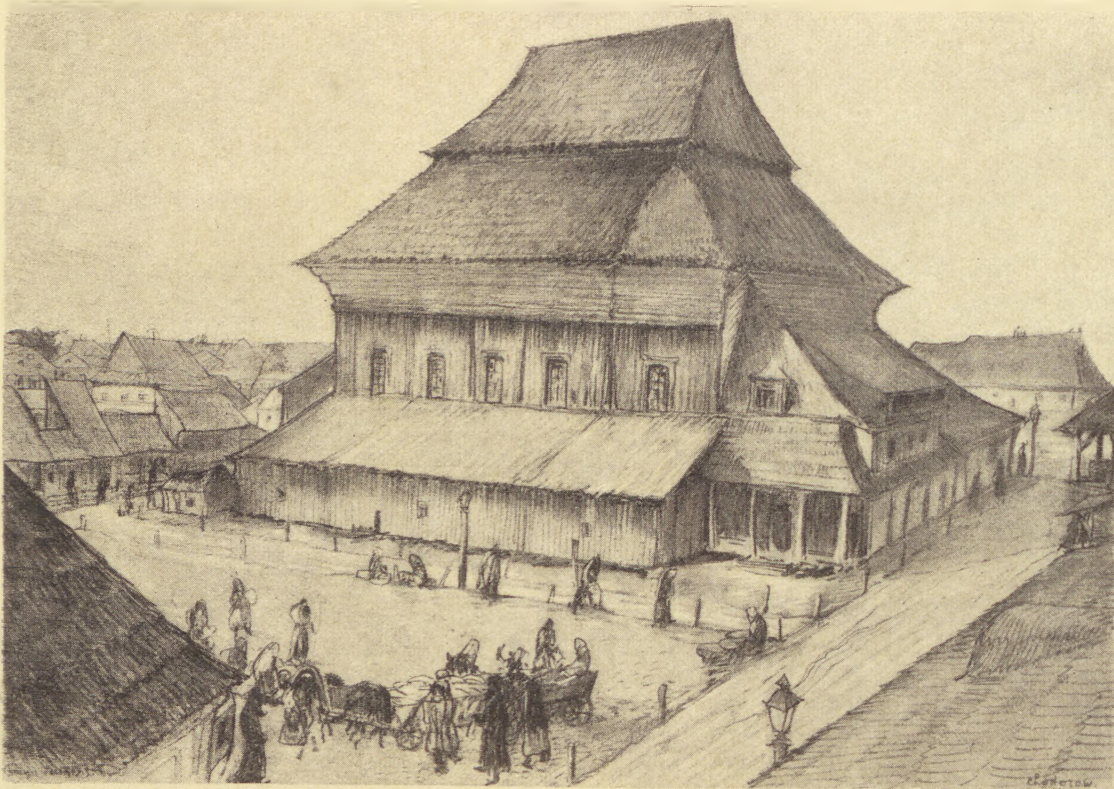
Loukomski herceg rajza a lengyelországi Chodorow régi faszinagógájáról — Holz Synagoge in Chodorow
