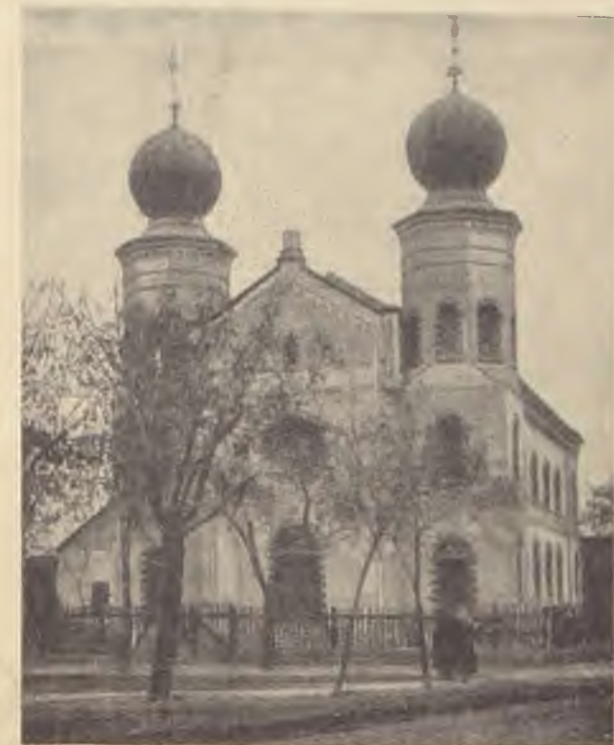
Die neue Synagoge in Jászberény
